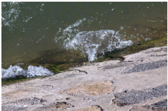
Estos Surtidores “No Son de Diseño” son Roturas que Impiden que el Nivel Suba
