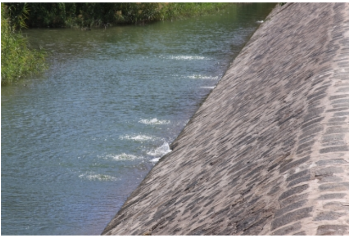
Cortina de la Presa de Mulegé por donde Escapa el Agua a Borbotones
